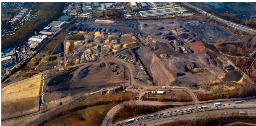
Luftaufnahme der Sanierungsarbeiten auf Emil Emscher
