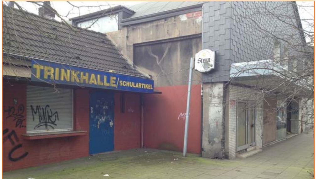
Hier ist nichts mehr zu machen. Manche Objekte sind energetisch nicht mehr zu sanieren. Dann hilft nur noch Abriss und Neubau.
