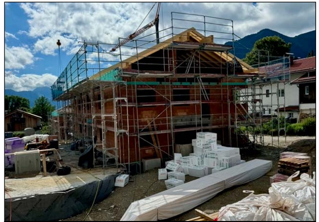
Neubau einer Wohnanlage. Immer häufiger finanziert von internationalen Banken.
