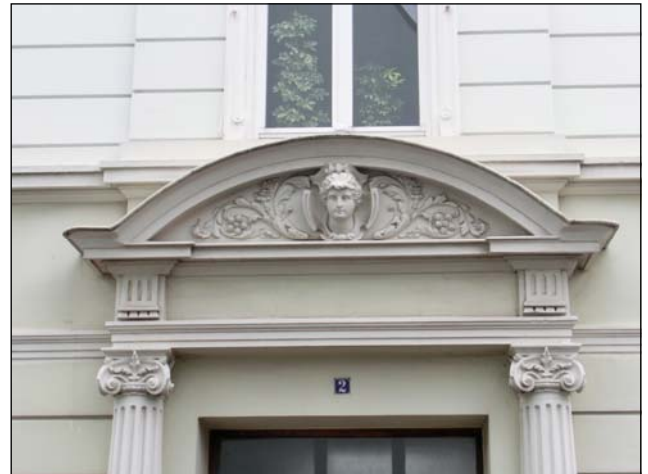
Altbau - lohnt die energetische Sanierung? Fast immer, meinen die Experten des Kieler Instituts für Weltwirtschaft.
