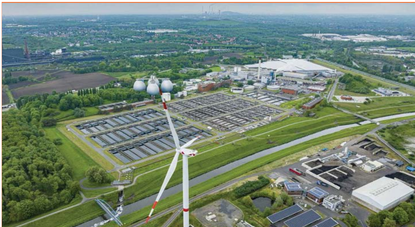
Die energieautarke Großkläranlage der Emschergenossenschaft in Bottrop: Zu sehen ist das Kläranlagengelände nördlich der Emscher und das Windrad südlich der Emscher. Der durch die Windenergieanlage produzierte Strom wird für den Betrieb der Kläranlage verwendet. Am oberen rechten Rand des Kläranlagengeländes ist zudem die weltgrößte solarthermische Klärschlamm-trocknungsanlage zu sehen – bestens zu erkennen an ihrem Glasbau.
