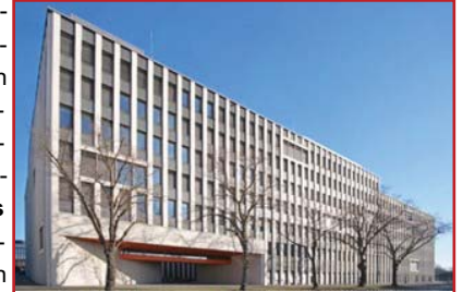
Bei älteren Bürogebäuden besteht zunehmend Handlungsbedarf. © Greif & Contzen
